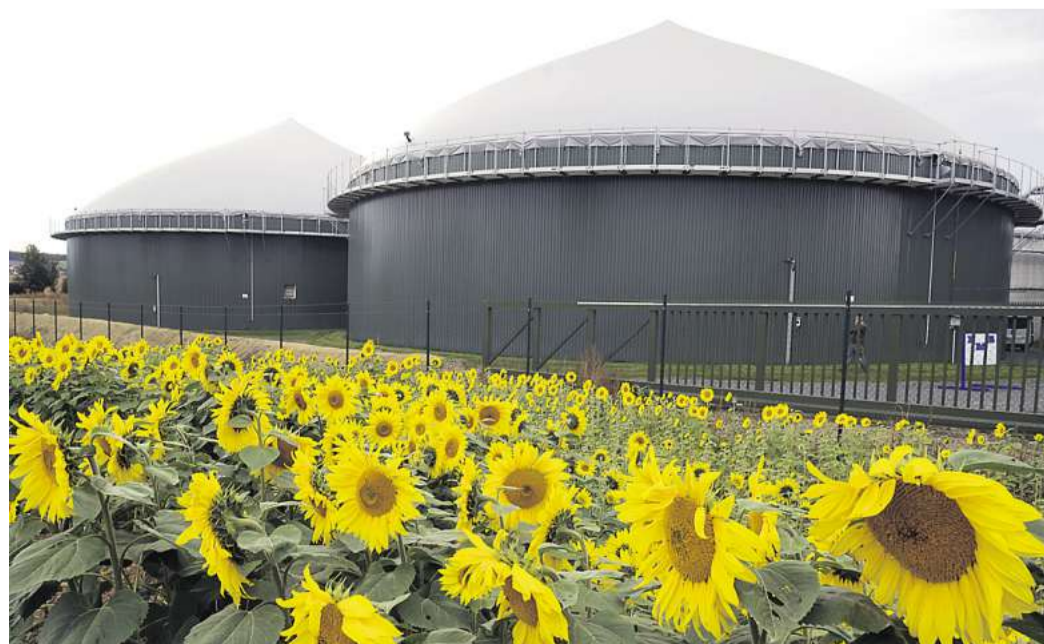
Bekommen schon bald Gesellschaft: Behälter der Biogasanlage Rosdorf.
