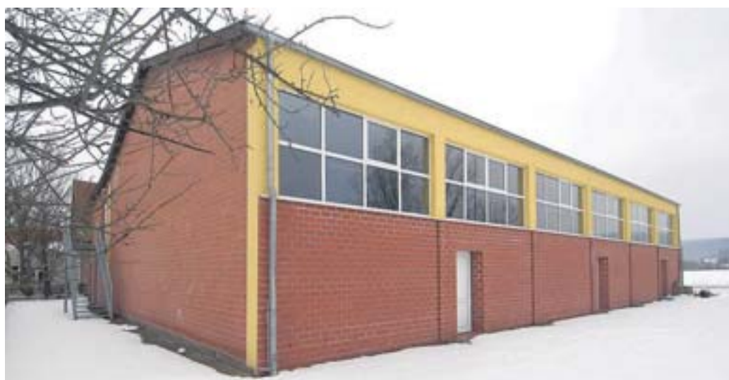
Sporthalle Lödingsen: Die Ostseite (mit der Treppe) soll in diesem Jahr saniert werden.
